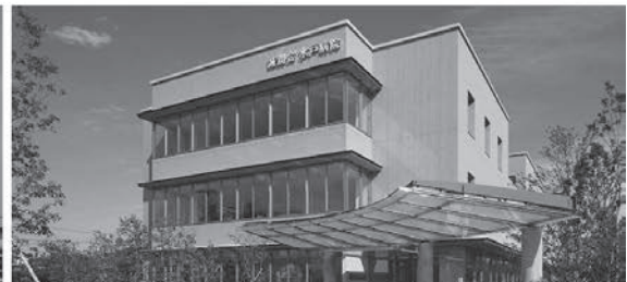
医療法人 誠潤会 水戸病院 / ガラス工事
